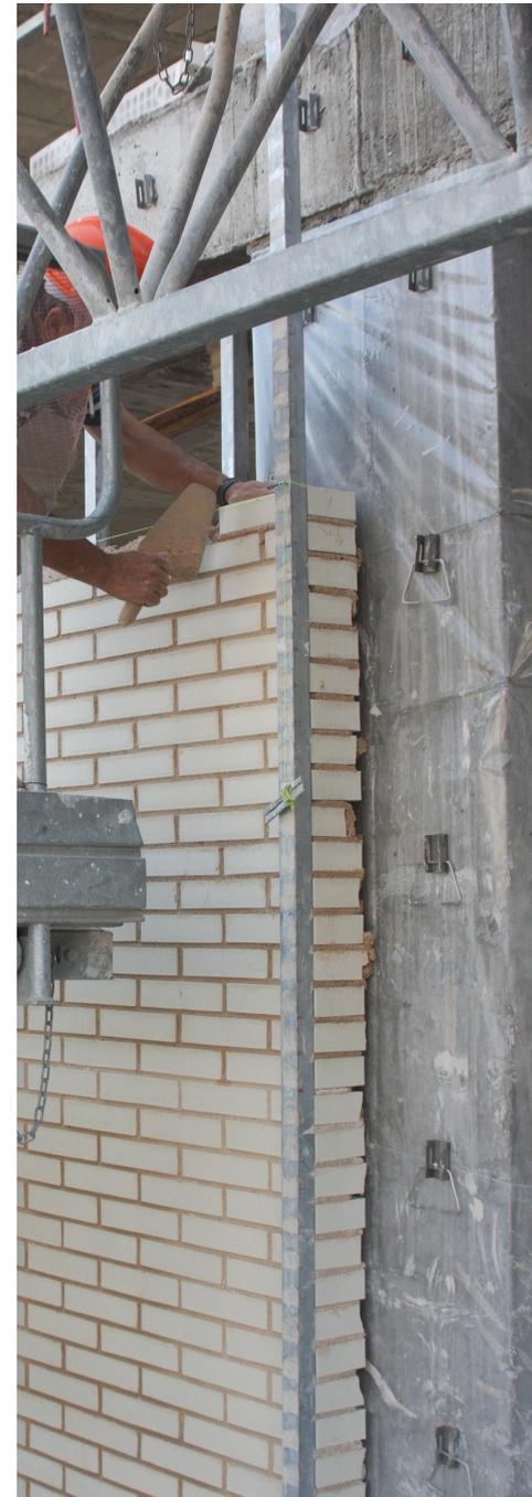
fábrica, de espesor comprendido entre 12 cm y 15 cm, una cámara con aislamiento, y un tabique interior. Todo ello suele estar confinado entre los forjados de piso, y ambas hojas sólo se conectan en torno a los huecos.
