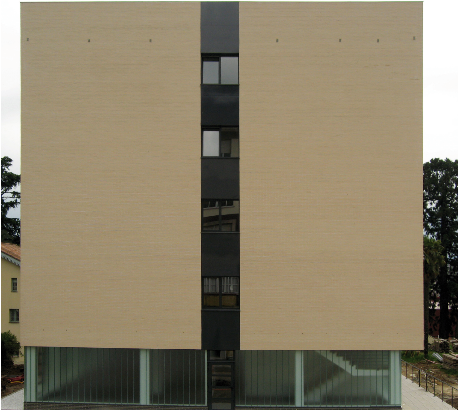
Fachadas de ladrillo caravista
