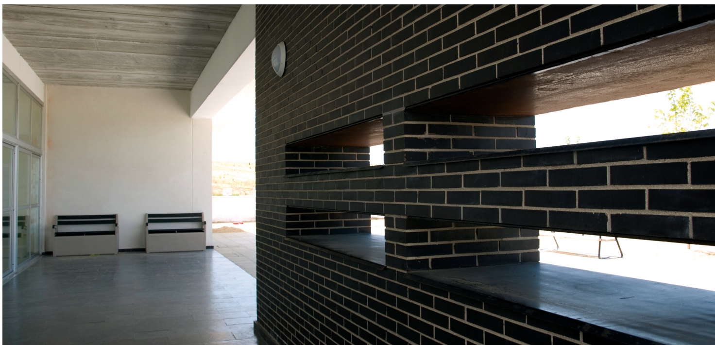
Fachadas de ladrillo caravista
