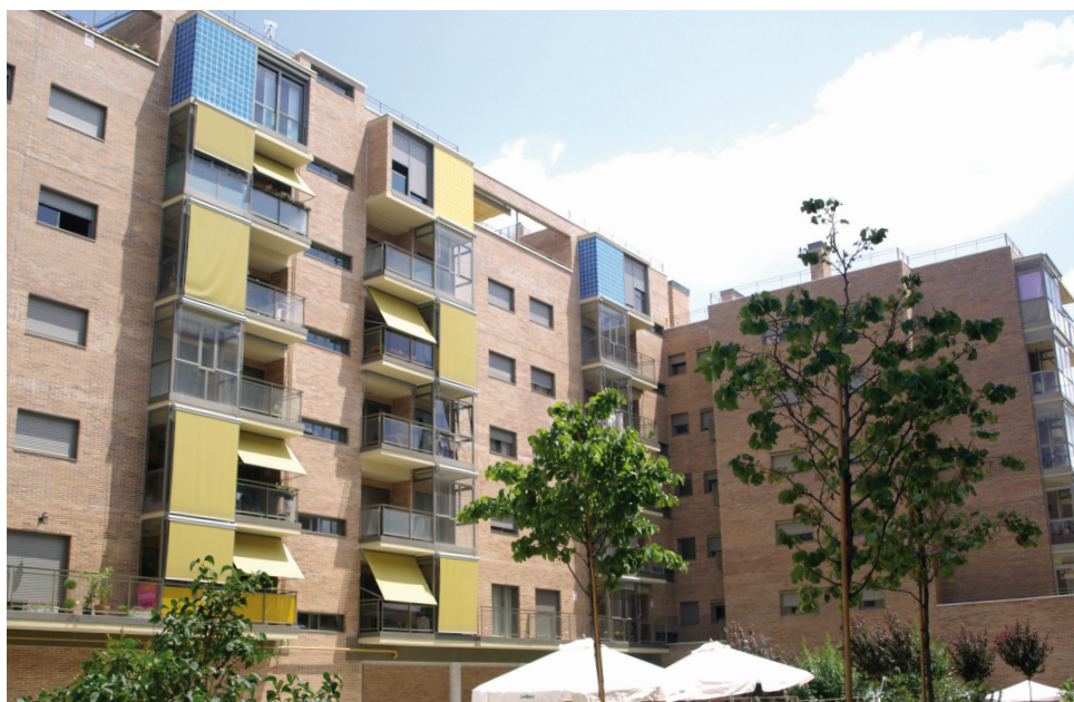
Fachadas de ladrillo caravista
