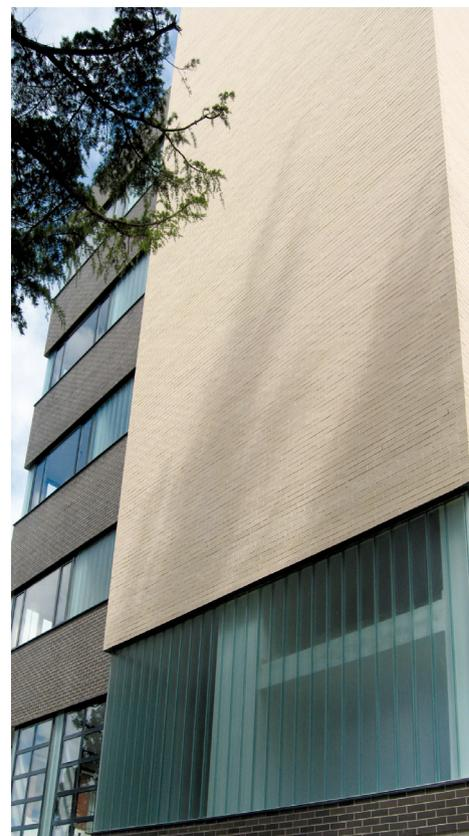
**EJEMPLO 9****Cerramiento autoportante anclado a frentes de forjado
