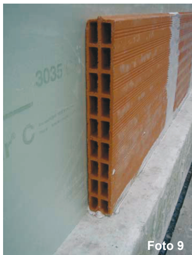
Fotos 9 y 10: Montaje de fábrica de ladrillo gran formato
