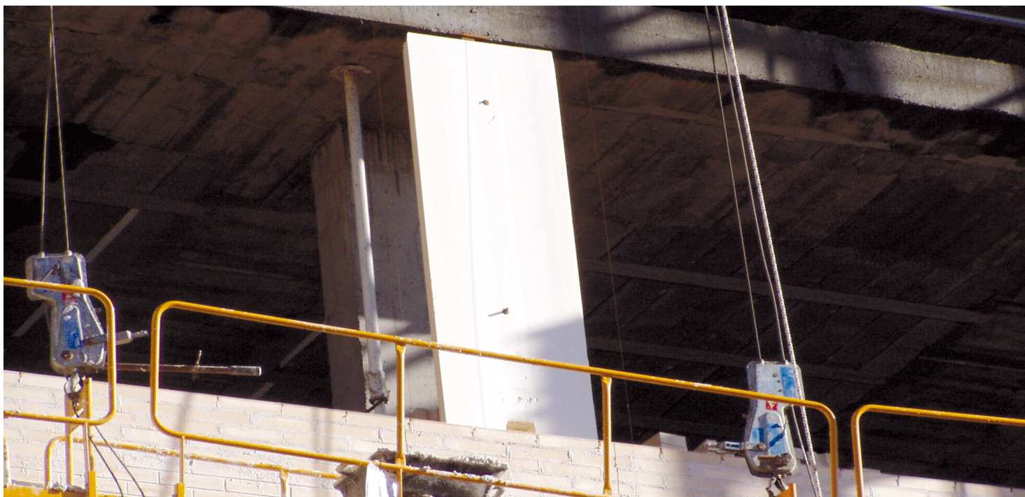
Revestimiento de soporte con material aislante
