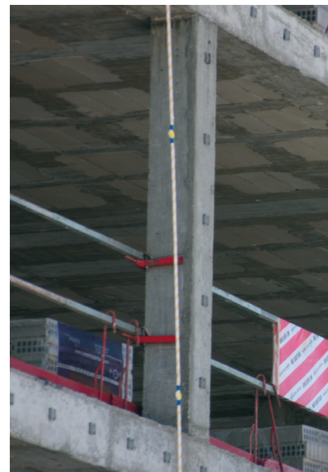
Anclajes a elementos estructurales
