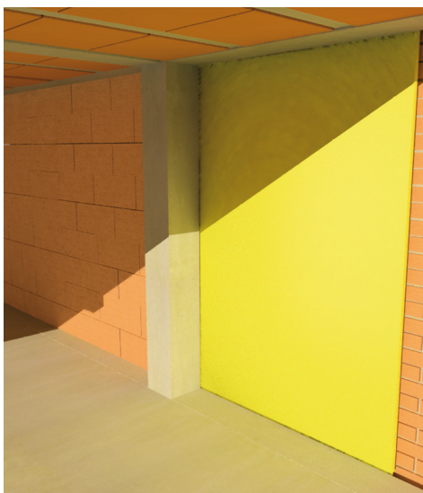
Montaje de los paneles rígidos de aislamiento
