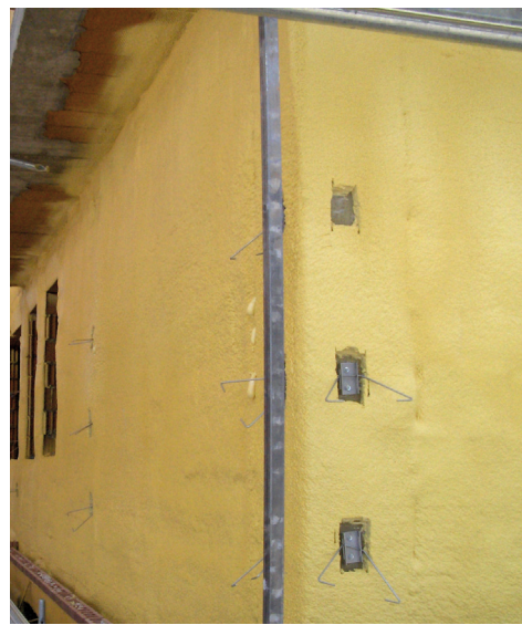
Aislamiento térmico de fachada ventilada
