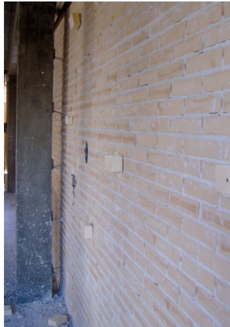
Aislamiento de panel rígido machi-hembrado con separadores
