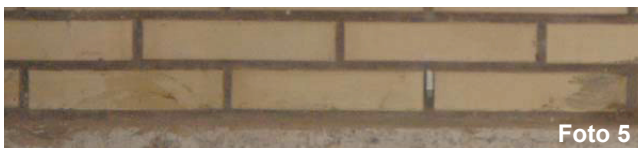
Fotos 4 y 5: Detalle de juntas verticales de ventilación libres de mortero
