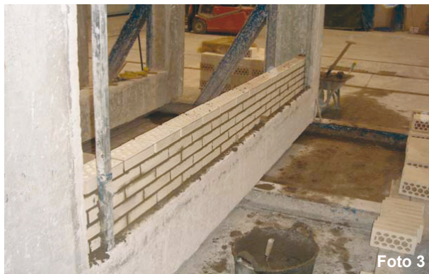
Fotos 1 - 3: Montaje de fábrica de ladrillo caravista con juntas verticales de ventilación
