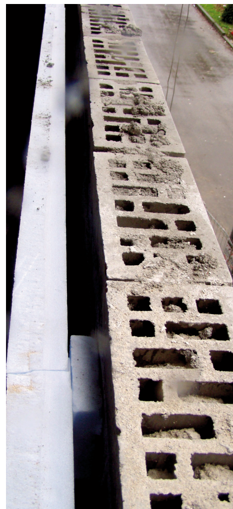
Colocación de panel aislante con separadores
