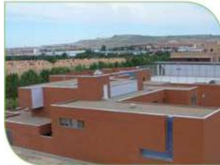
Centro deportivo y cultural en Valladolid (España)
