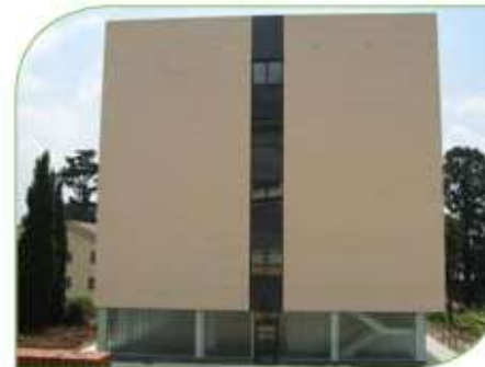
Edificio Fundoma en Asturias (España)
